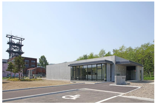
施設外観、左奥は住友赤平炭鉱第一立坑櫓
