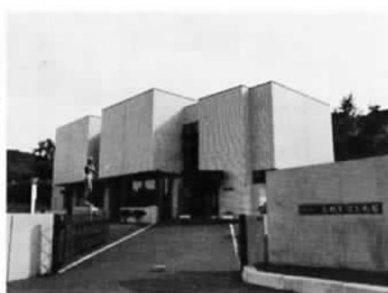
（札幌彫刻美術館本館全景）
