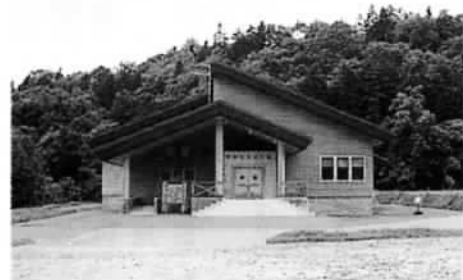
真狩村羊蹄ふるさと館全景
