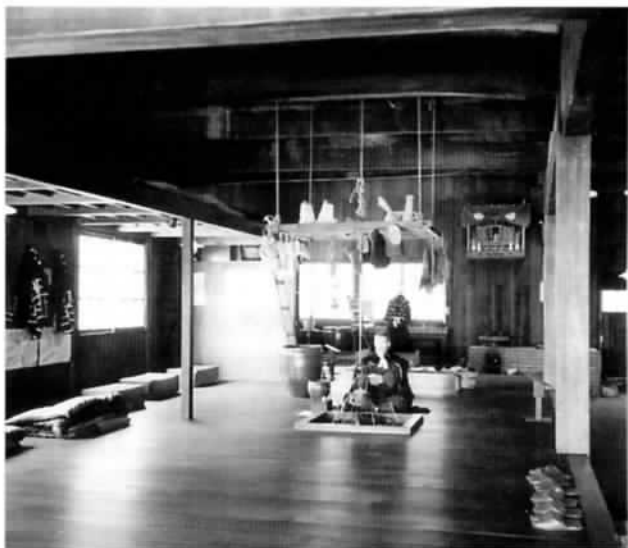
旧川村家番屋・内部
