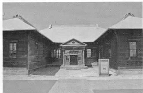
旧樺戸集治監本庁舎
