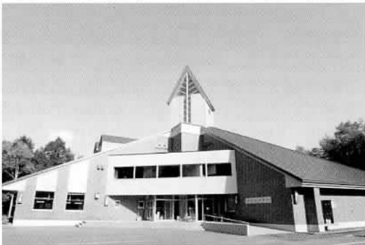
平成21年度は、ブナセンターの外装も改修しました
