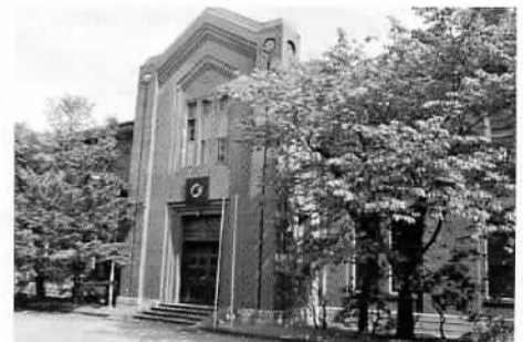
王子製紙苫小牧工場旧事務棟
