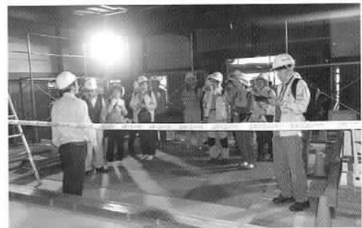
改修中の上國寺本堂での見学会の様子
