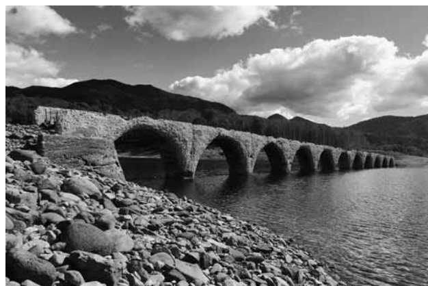
旧国鉄士幌線アーチ型橋梁
