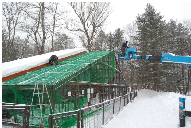
ワシタカ施設の工事
