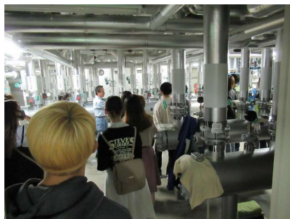
ボイラー室で解説を聞く高専の生徒たち
